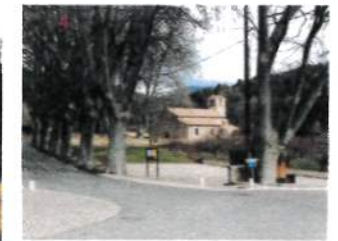
Eglise Saint Barthélemy et le site inscrit à ses abords. Vue depuis le sud ouest. (© studio bt)
