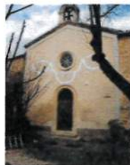
Ancienne chapelle Saint-Joseph (1873), aujourd'hui aménagée en bibliothèque communale. (© studio bt)
