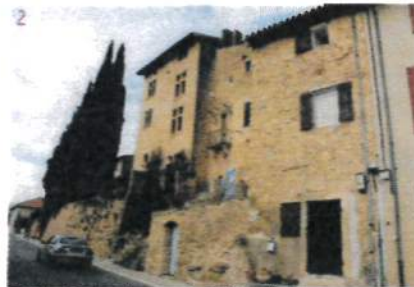
Hôtel des Bouliers. Vue du sud-est. (© studio bt)
