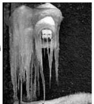
Si le compteur n'a pas éclaté, il faut tout d'abord couper l'eau afin d'éviter toute inondation au moment du dégel et utiliser une source de chaleur (un sèche-cheveux par exemple) qui débloquera la canalisation gelée.
